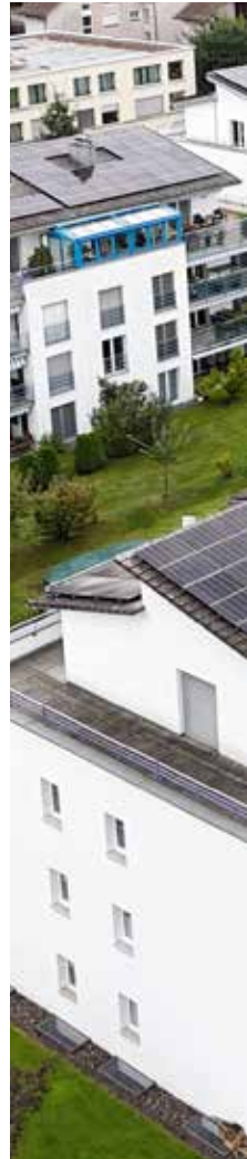
Solaranlage bei der Überbauung Florapark
